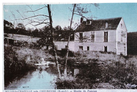
Moulin de Fauveau - source: web commune -
